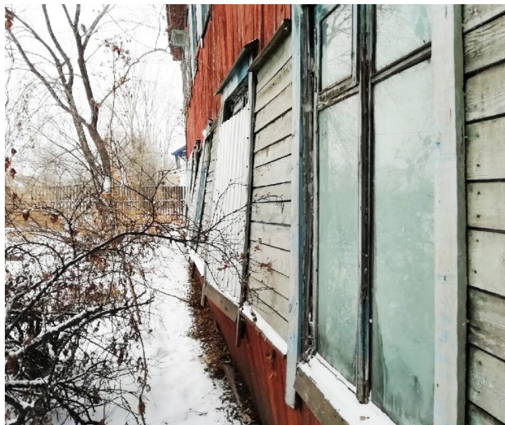
На фото: стена довоенного барака на Кавалерийской, 36 вываливается на улицу (слева). По фасаду пятиэтажки на ул. Пионерской, 60 А («Санта-Барбара») проходит трещина (справа).
